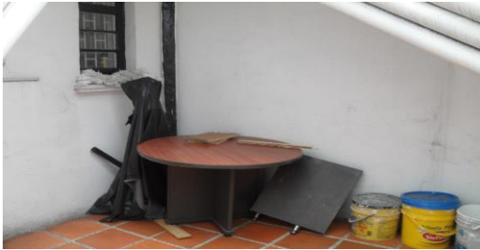
Fuente: Sede carrera 17 No.38-30 - OFB
